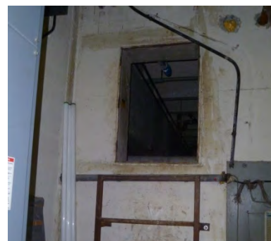
Missing hatch door
