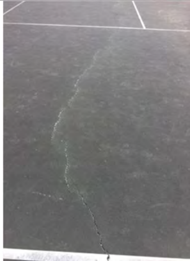
Longitudinal crack
