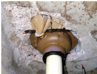
Damageg slab at pipe pegetratig g
